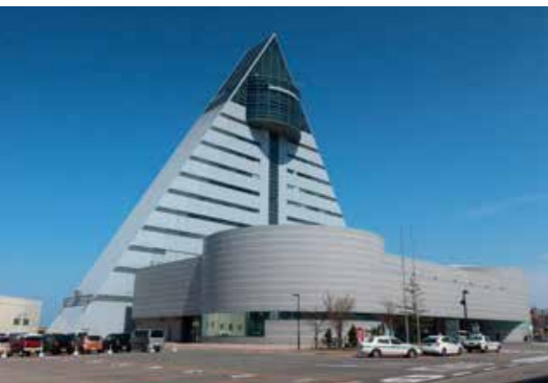
▲アスパムの建物は、青森の頭文字であるAの形となっている
