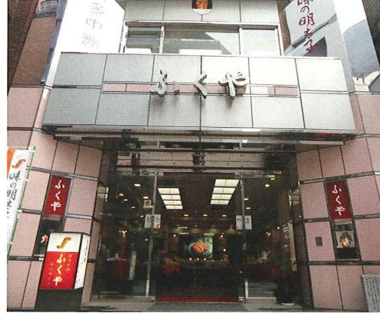
博多区中洲にある本社ビル。1階の店舗は明るく入りやすいイメージ
