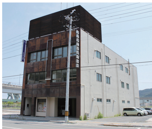
補助金を活用して復旧した 釜石商工会議所会館（24年4月撮影）
