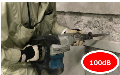
【従来工法】電動ハンマーによるモルタル撤去
