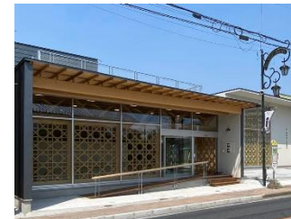
中心市街地に立地する 商工会館の木質化 (飯能市)
