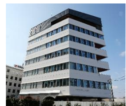
▲倉敷商工会議所(岡山県)の新会館は、非常時には市民の一時避難所としても活用できるよう設計された。
