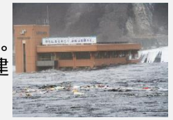
▲津波は商工会議所会館2階天井まで押し寄せた
