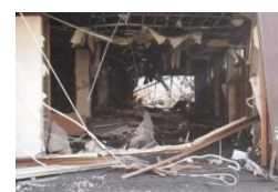
▲津波で一階が奥まで突き抜けた(金石商工会議所)
